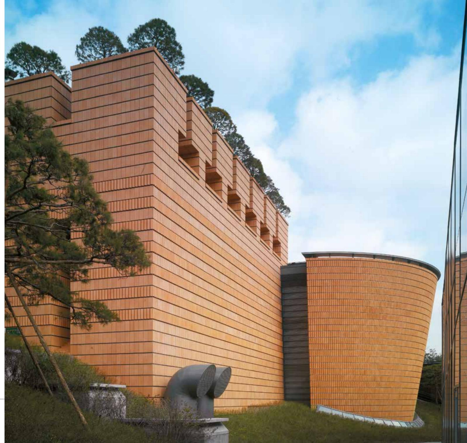
L'involucro esterno del Museo Samsung è completamente ricoperto in terracotta, caratterizzato "da un elemento triangolare a cuspidi, in cui la forma stessa permette alla luce di giocare in modo da ottenere una cromia diversa di colore. Sono combinati due elementi uno completamente piatto e l'altro aggettante" l'elemento triangolare è stato applicato a tutta la facciata, che è un semplice volume parallelepipedo affiancato ad un cono rovesciato.
