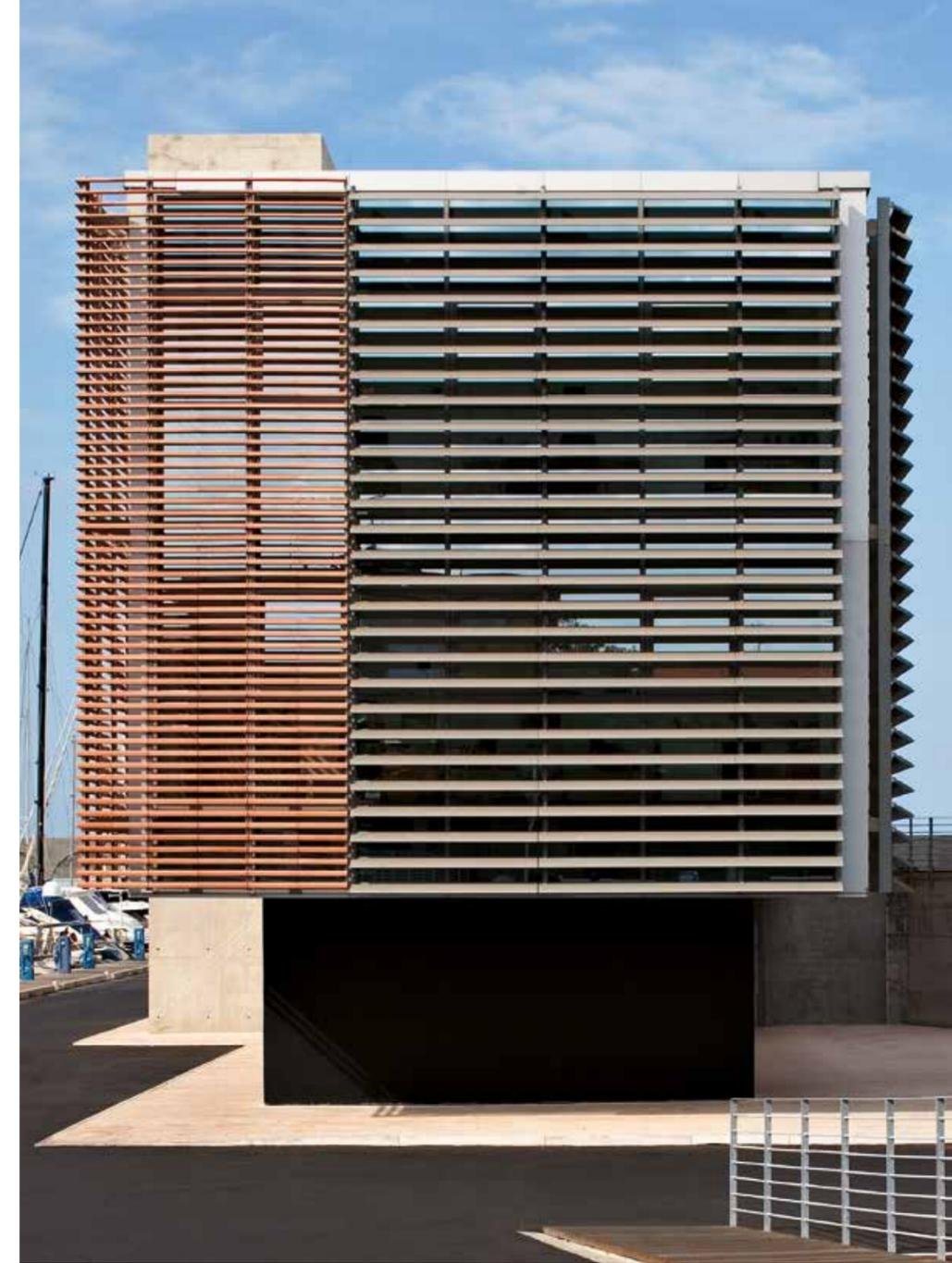
Il fronte principale è schermato da un frangisole di elementi in cotto con finitura "litos", realizzato con listelli a sezione ovale, fissati con sistema meccanico. Vedendo lo schermo dall'esterno, il sistema di ancoraggio è occultato e mette in evidenza la pelle naturale del cotto, dove i componenti sono posizionati in orizzontale con angolazione variabile.
