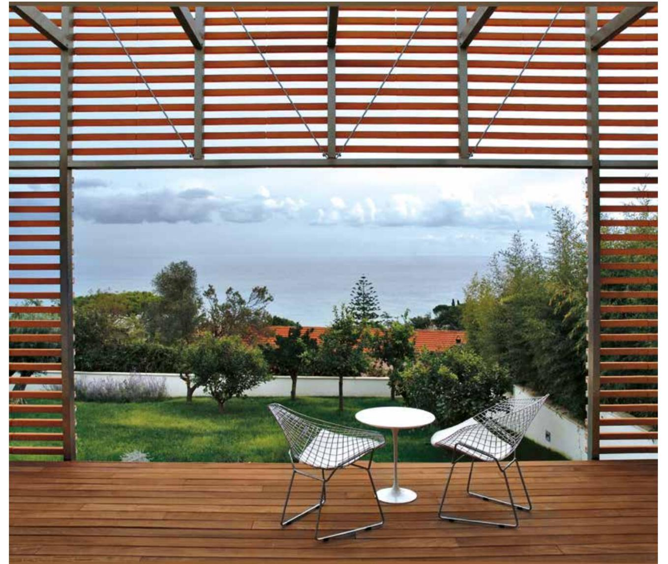
Schermo esterno avanzato a creare frangisole in porzione orizzontale e verticale, con elementi in cotto con finitura arrotrato a sezione quadrata di dimensioni 5x5 cm. Le strutture primarie e secondarie sono del tipo meccanico realizzate con acciaio inox AISI 304 spazzolato.
